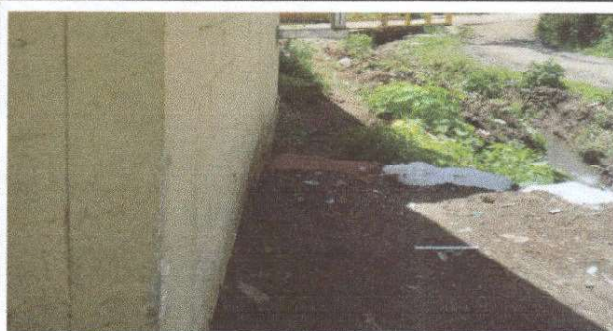
Foto 2: Finalización de estabilización de suelo para evitar el deslizamiento del área de cocina.
