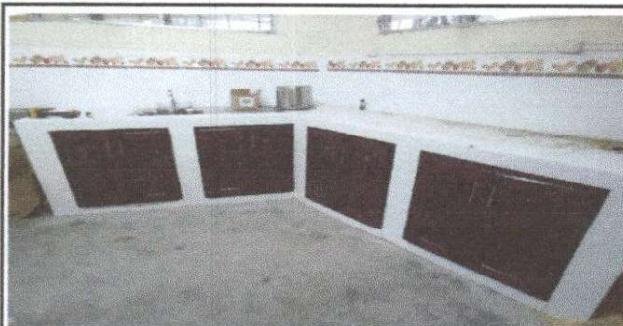
Foto 5: Finalización de construcción de lavatrastos y gabinetes.
