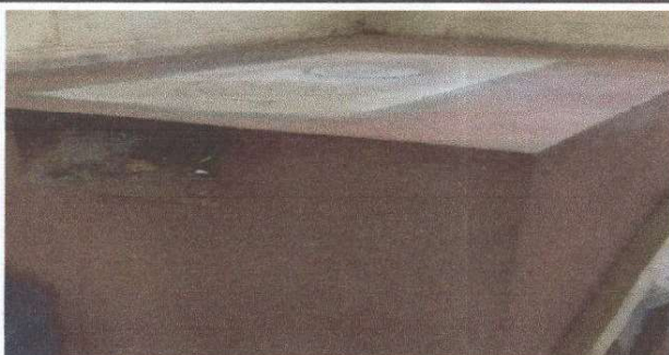
Foto 4: Finalización de remodelación de plancha.
