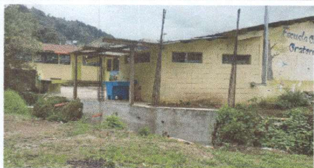
Foto 1: Finalización de la construcción de muro de contención para evitar inundaciones y deslizamientos
