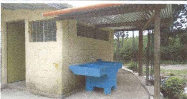
Foto 3: Finalización de construcción de muro.
